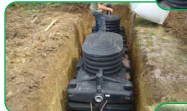
Le remblai est constitué de graviers et a été réalisé par couches compactées de 30 cm d'épaisseur.
